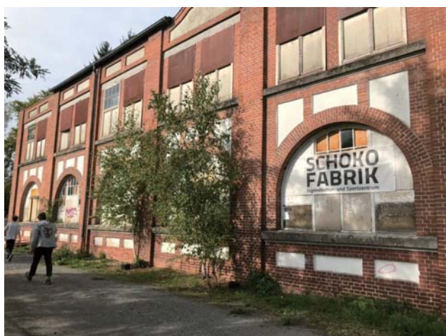
元チョコレート工場 煉瓦造りの外壁
